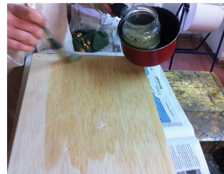
Para sellar la madera aplicamos cola de conejo caliente sobre las puertas por ambas caras incluidos los cantos.
