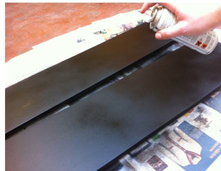
Aplicar sobre la trasera aparejada de las puertas pintura negra mate en spray. Se han aplicado cuatro manos.
