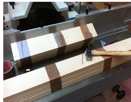
Unir con celo y clavos los listones reservados para la armadura interior de los cajones.
