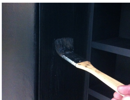
Aplicar una mano densa de cera express con un poco de óleo negro para potenciar el ebanizado.
